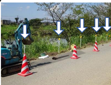
道路境界部に反射板の付いたボール（⇒の下方）の設置工事が行われました。
