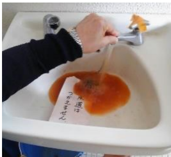
「水道はつかえません」と長期間張り紙されたトイレの手洗い(蛇口からは茶色の水が出てきた)。
