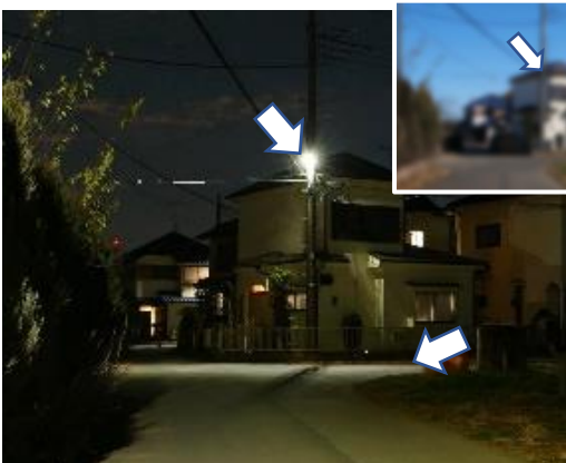
電柱にLEDライトを設置（上の⇒部）したことで、道路が明るくなった（下の⇒部）。
